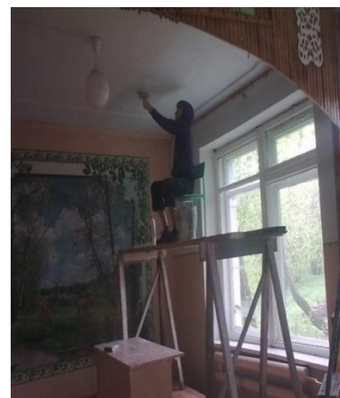
Побелка помещений школы
